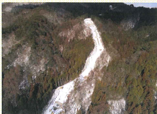
水圧管路の状況
