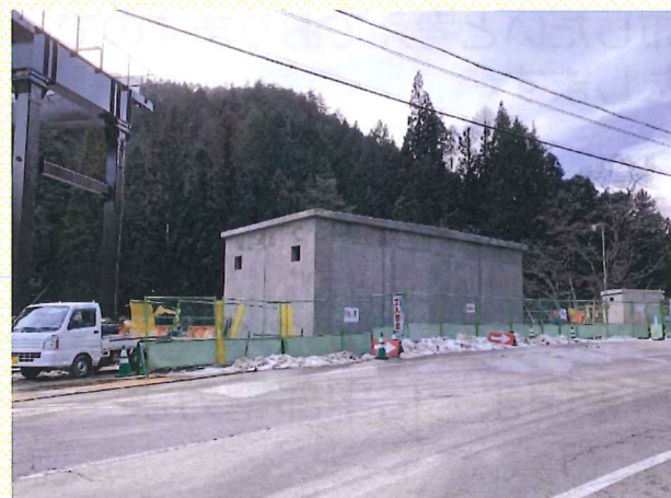
サービス建屋（国道256号線から）
