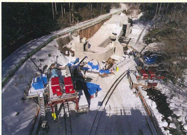
小黒川えん堤、導水路トンネル抗口の状況
